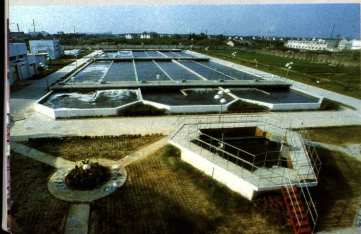
Очистная станция мощностью обработки 20 тыс. т воды в день.
